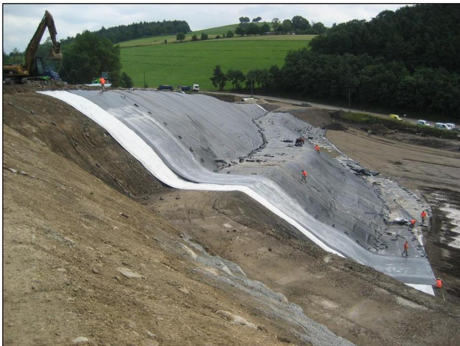
Figure 5 : Vue sur un casier en cours de création (pose de la barrière active) (Source : SUEZ RV Borde Matin)
